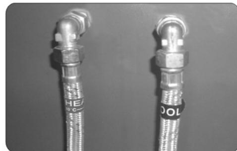
Слив всю оставшуюся воду из заранее подготовленных труб водопровода, установите на них 2 латунных коленных соединения вместе с прокладками. Возьмите 2 металлических шланга, отмеченных синим и красным цветом соответственно, и подсоедините их трубам водопровода для холодной и горячей воды, а также к крану налива.
