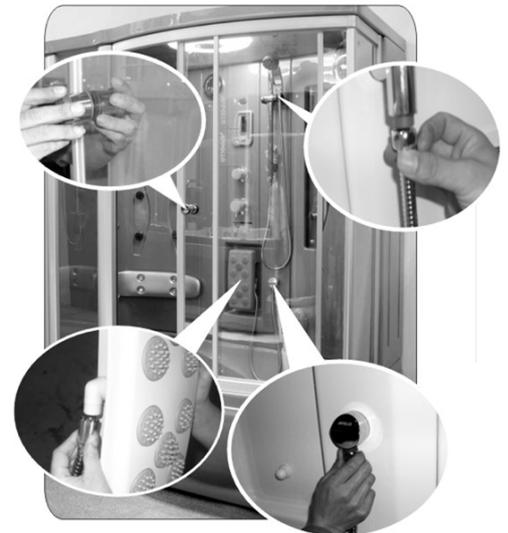
**ШАГ 13****Нанесение герметика:**
