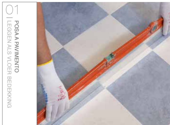
01 POSA A PAVIMENTO | LEGGEN ALS VLOER BEDEKKING 01 IL SOTTOFONDO DEVE ESSERE PERFETTAMENTE PIANO. 01 DE ONDERGROND MOET VOLLEDIG VLAK ZIJN.
