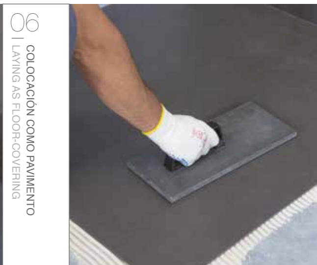
06 COLOCACIÓN COMO PAVIMENTO | LAYING AS FLOOR-COVERING 06 BATTERE LA SUPERFICIE CON UN MARTELLO DI GOMMA, PER ELIMINARE EVENTUALI BOLLE D'ARIA. ACCERTARSI SEMPRE CHE GLI SPIGOLI E I BORDI SIANO PERFETTAMENTE INCOLLATI. NON CALPESTARE IL PAVIMENTO DURANTE O SUBITO DOPO LA POSA E RISPETTARE I TEMPI INDICATI DAL PRODUTTORE DELL'ADESIVO. 06 KLOP DE TEGEL AAN MET EEN RUBBER HAMER OM LUCHTBELLEN TE VERWIJDEREN. ZORG ERVOOR DAT DE RANDEN EN DE HOEKEN VOLLEDIG VAST ZITTEN. LOOP NIET OP DE VLOER TIJDENS OF NET NA HET LEGGEN.
