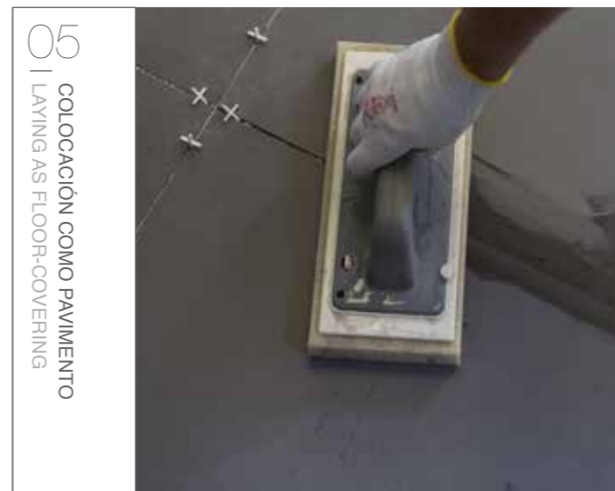
05 COLOCACIÓN COMO PAVIMENTO | LAYING AS FLOOR-COVERING 05 SI CONSIGLIA UNA FUGA MINIMA DI 2 MM PER INTERNI E DI 5 MM PER ESTERNI. UTILIZZARE GLI APPOSITI DISTANZIATORI PER OTTENERE LE FUGHE DESIDERATE. 05 EEN MINIMALE VOEG VAN 2 MM WORDT AANGERADEN WANNEER DE VLOER BINNEN WORDT GELEGD. VOOR BUITEN WORDT EEN VOEG VAN 5 MM GEADVISEERD.
