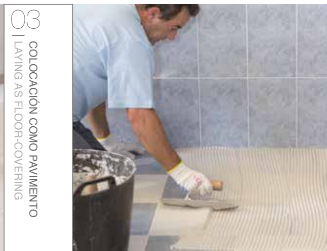
03 COLOCACIÓN COMO PAVIMENTO | LAYING AS FLOOR-COVERING 03 STENDERE OGNI VOLTA L'ADESIVO SOLO SULLA PARTE DI SOTTOFONDO SULLA QUALE DEVE ESSERE POSATO IL PEZZO: NON APPLICARE SU VASTE AREE PER EVITARE PERDITE DI ADERENZA. 03 BRENG DE LIJM ALLEEN AAN OP HET GEDEELTE WAAR DE VOLGENDE TEGEL KOMT LIGGEN. SMEER GEEN GROTERE STUKKEN IN MET LIJM OM VERMINDERING IN AANHECHTING TE VOORKOMEN.
