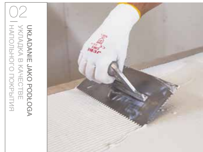
03 UKŁADANIE JAKO RODŁOGA UKŁADKA В КАЧЕСТВЕ НАПОЛЬНОГО ПОКРЫТИЯ
