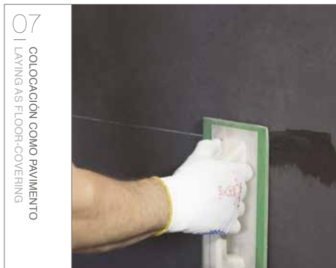
07 COLOCACIÓN COMO PAVIMENTO | LAYING AS FLOOR-COVERING 07 PRIMA DI PROCEDERE ALLA STUCCATURA, RISPETTARE I TEMPI NECESSARI INDICATI DAL PRODUTTORE DELL'ADESIVO: POSSONO ESSERE UTILIZZATI PRODOTTI CEMENTIZI O A BASE DI RESINA EPOSSIDICA. QUESTI ULTIMI GARANTISCONO UNA MAGGIORE UNIFORMITÀ E SOLIDITÀ DEI COLORI. 07 WACHT MET VOEGEN TOT DE LIJM VOLDOENDE UITGEHARD IS (NEEM DE ADVIEZEN VAN DE LIJMFABRIKANT IN ACHT). CEMENT OF EPOXY VOEGEN KUNNEN GEBRUIKT WORDEN OM EEN BETERE KLEUR EN MEER UNIFORMITEIT TE KRIJGEN.
