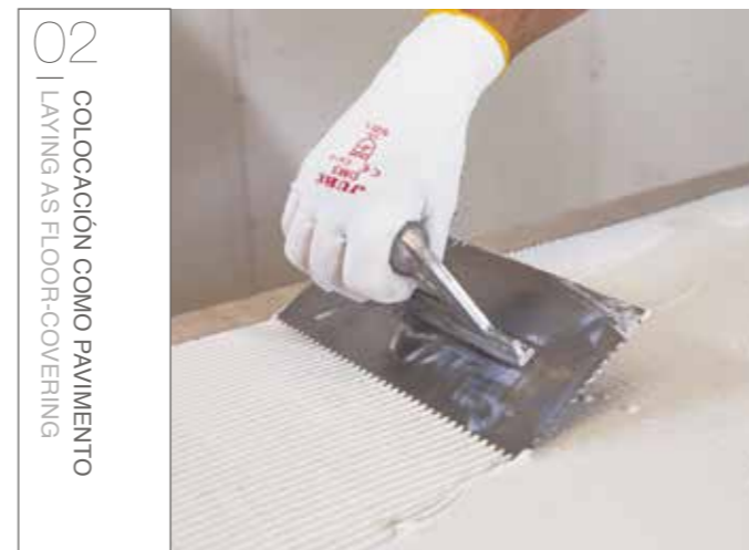
02 COLOCACIÓN COMO PAVIMENTO | LAYING AS FLOOR-COVERING 02 APPLICARE L'ADESIVO CON LA TECNICA DELLA DOPPIA SPALMATURA A LETTO PIENO, PRIMA SUL RETRO DEL PEZZO USANDO UNA SPATOLA A DENTI PIATTI DA 3 MM E POI SUL SOTTOFONDO CON UNA SPATOLA A DENTI INCLINATI DA 6 MM, AVENDO CURA DI COPRIRE GLI SPIGOLI E I BORDI, EVITANDO LA PRESENZA DI BOLLE D'ARIA TRA IL SOTTOFONDO ED IL PEZZO. 02 BRENG DE LIJM AAN OP BEIDE OPPERVLAKKEN ZONDER GATEN OPEN TE LATEN. DE LIJM EERST AANBRENGEN OP DE TEGEL MET EEN KAM VAN 3 MM EN DAARNA OP DE ONDERGROND MET EEN KAM VAN 6 MM. VERMID LUCHTBELLEN.
