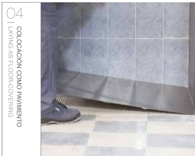
04 COLOCACIÓN COMO PAVIMENTO | LAYING AS FLOOR-COVERING 04 APPOGGIARE DELICATAMENTE LA LASTRA LUNGO IL LATO LUNGO, INCLINARLA LEGGERMENTE, QUINDI ABBASSARLA E FARLA ADERIRE AL SOTTOFONDO. 04 ZET DE PLAAT OP ZIJN LANGE KANT VOORZICHTIG OP DE GROND EN HOUDT HEM ENIGSZINS SCHEEF. LEG DE PLAAT NEER DOOR HEM NAAR BENEDEN TE LATEN ZAKKEN EN AAN DE STEUN TE BEVESTIGEN.
