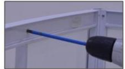
Рисунок 51. Зафиксируйте положение профиля №2 саморезом через отверстия в верхней направляющей дверей.
