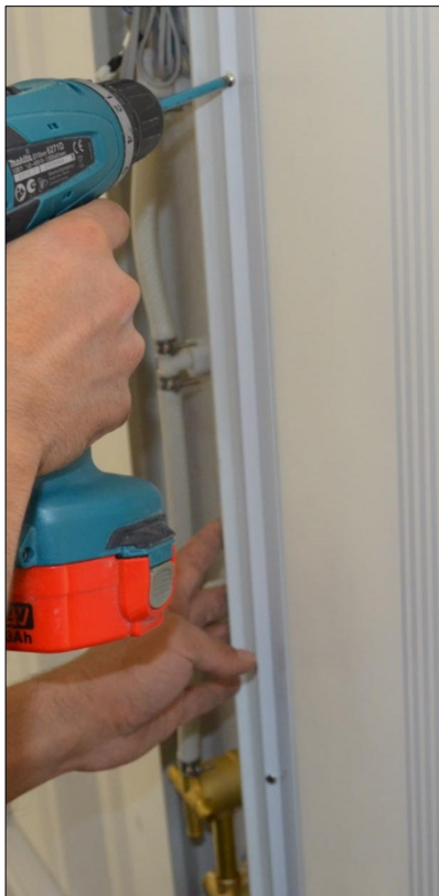
Рис. 36. Установка центральной стойки
