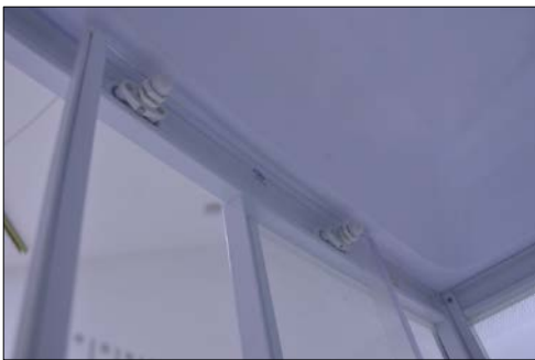
Рис. 56. Установка двери на верхнюю направляющую
