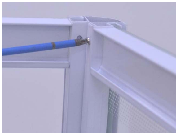
Рис. 42. Соединение профиля бокового стекла со стойкой сверху
