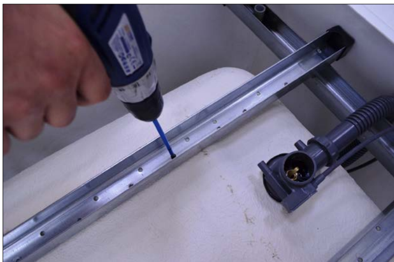
Рис. 21. Соединение поддона и каркаса.
