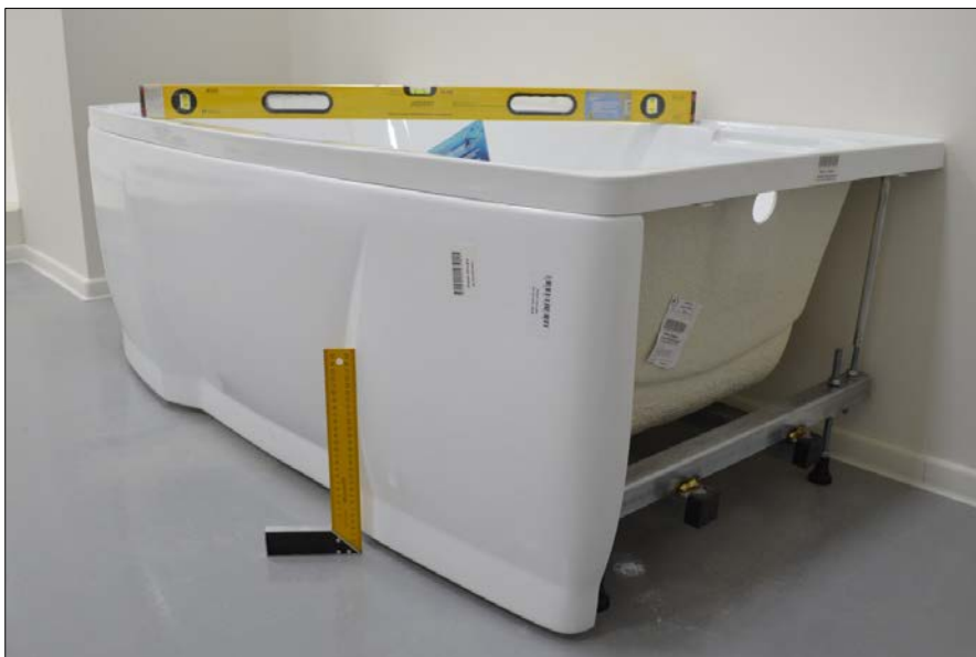
Рис. 28. Поддон на каркасе в рабочем положении
