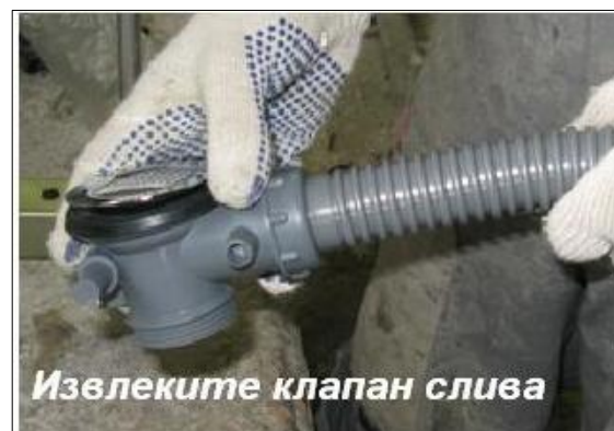
Рис.8. Извлечение клапана слива
