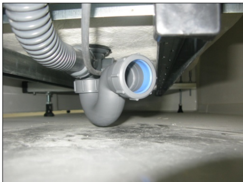
Рис.17. Установленное колено сифона.
