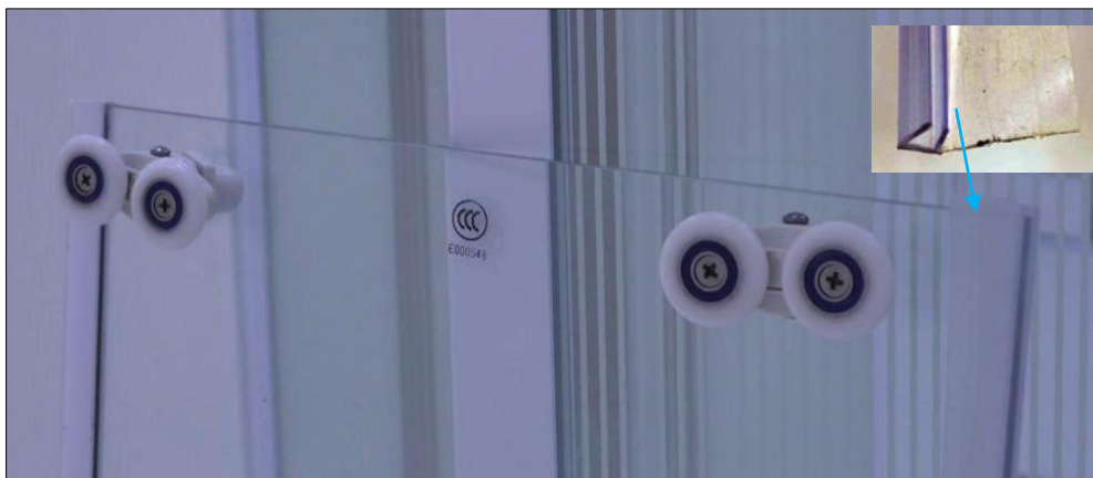
Рис. 55. Установка уплотнителя стекла двери
