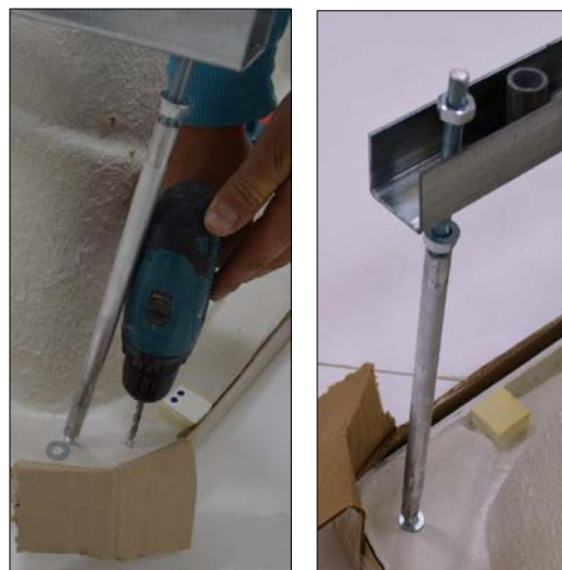
Рис. 22-23. Установка стоек.
