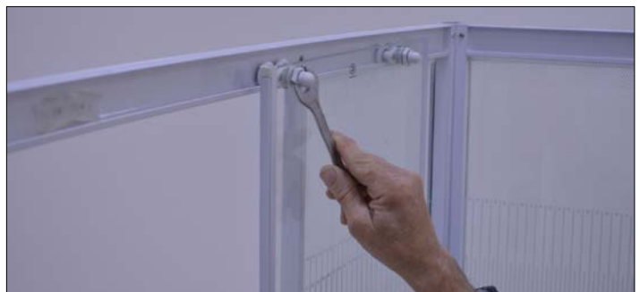
Рис. 57. После регулировки зафиксируйте гайками положение эксцентриков, наверните декоративный колпачок
