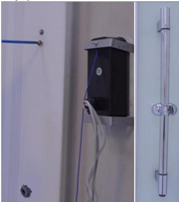
Рис.46. установка держателя для лейки
