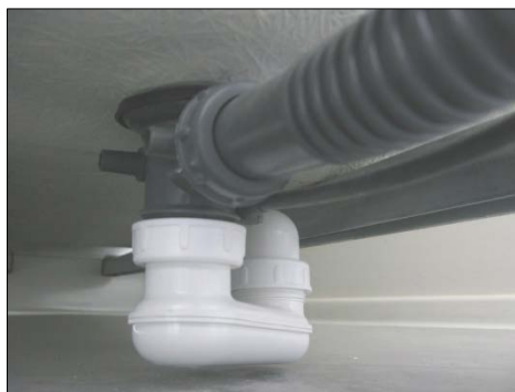
Рис.17. Установленное колено сифона.
