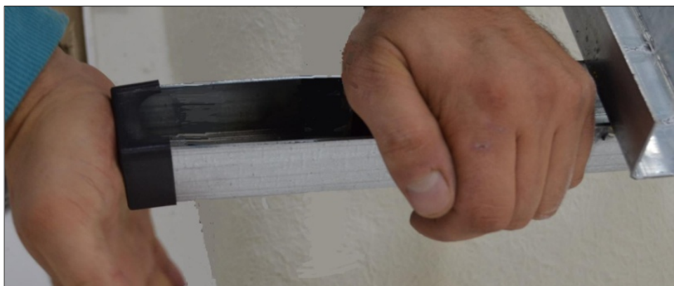
Рис. 18. Установка заглушек каркаса
