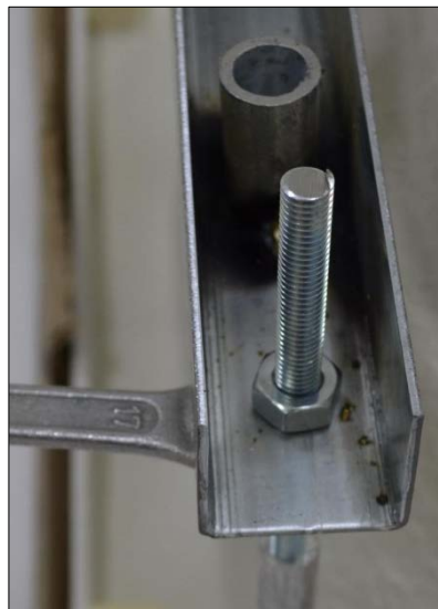
Рис. 25. Фиксация верхнего конца стойки
