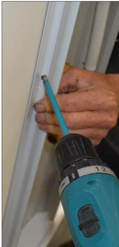
Рис. 37. Скрепление второго заднего стекла с центральной
