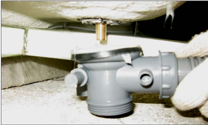
Рис.12. Совмещение крышки корпуса слива со сливным отверстием поддона
