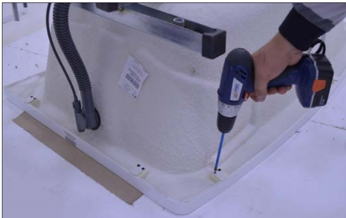
Рис. 19. Установка зажимов для экранов.
