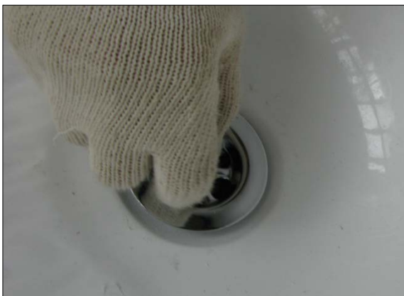
Рис. 13. Наживка соединения слива
