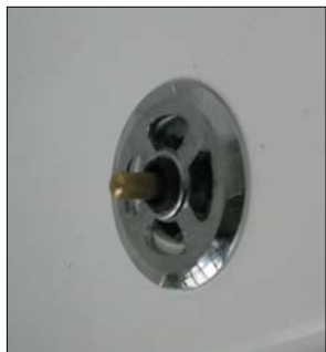
Рис. 15. Перелив установлен
