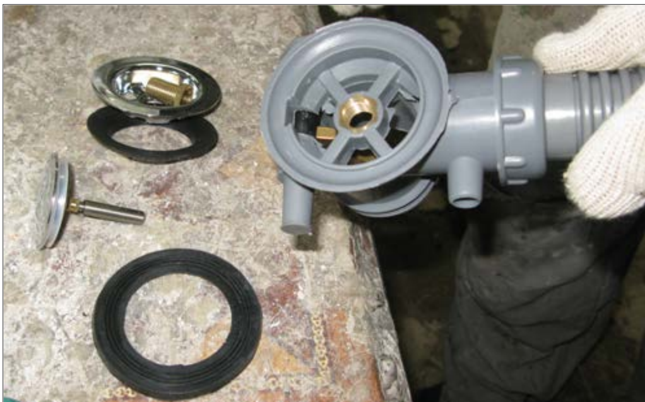
Рис.9. Подготовка корпуса слива
