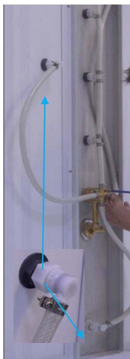
Рис. 63. Подключение шлангов подвода воды
