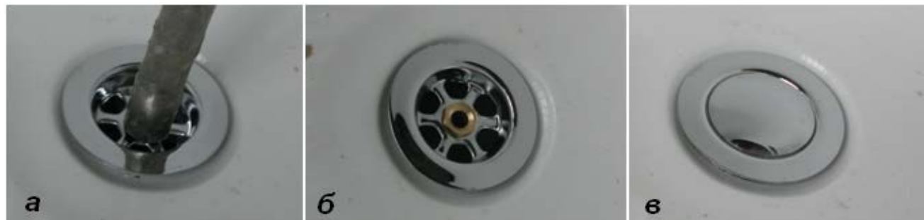
Рис.14. Закрепление слива. а-затяните соединение торцевым ключом: б- уберите ключ; в- вставьте клапан.
