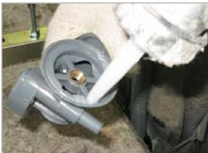
Рисунок 10. Нанесите герметик в канавку корпуса слива
