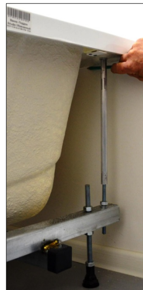
Рис. 29. Отметьте на стене положение нижней кромки борта
