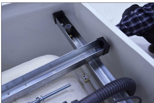
Рис.20. Уточнение положения каркаса на днище поддона.
